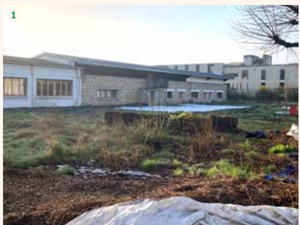
① En 2020 on a découvert que le sol de notre potager était pollué. Sur la recommandation des experts, on a dû déplacer ce qu'on avait planté, mettre du géotextile sur le sol puis le recouvrir d'une nouvelle terre. ② La nouvelle terre vient d'être répartie sur toute la surface du potager.
